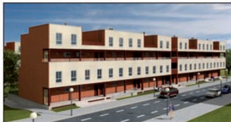
REHABILITACIÓN DE LA PARCELA 16 DEL "PARQUE ALERÍA" (MADRID) PARA VIVIENDAS. OBRA EN EJECUCIÓN
